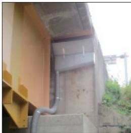
橋梁 簡易排水装置
