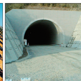
トンネル内排水管 (センタードレン)
