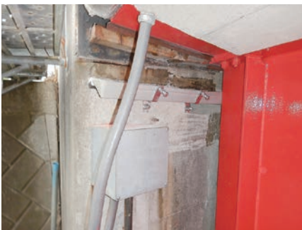
胸壁にアンカー打設し、製品を取り付けます
