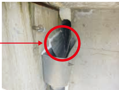
設置後遊間内 遊間内に簡易排水装置TYPE-C設置 ○部
