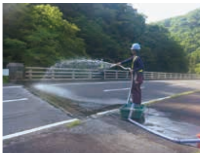
伸縮装置付近に散水
