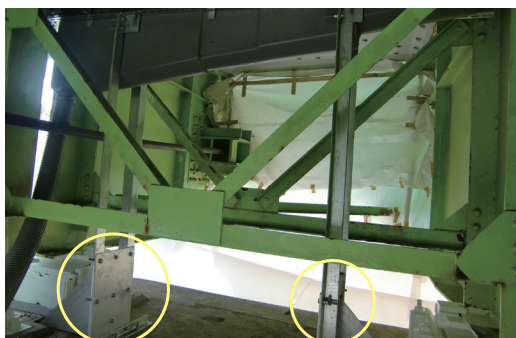
スタンド方式 (橋座アンカー固定)
