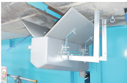
吊り方式 (床版アンカー固定)
