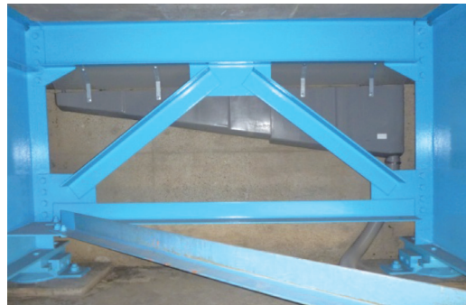
桁間部への本体設置
