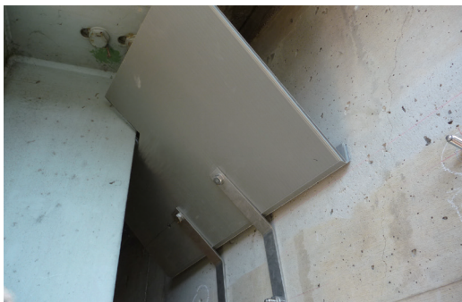
主桁パネルの設置
