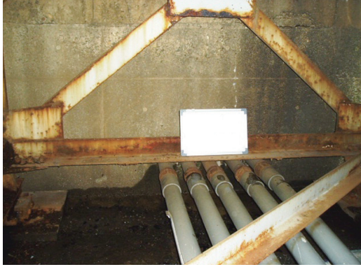
橋台壁面 塗装前
