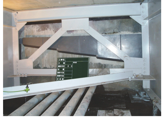
橋台壁面を塗装の上、トータク簡易排水装置を設置しました。
