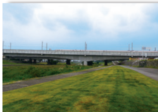
石川 北陸新幹線 加賀犀川橋りょう (2008年)
