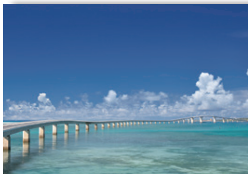
沖縄 伊良部大橋 (2015年)
