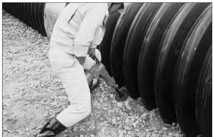
(※ 写真はポリメタルスーパーの施工例)
