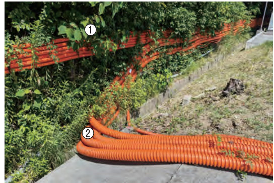
①トータクケーブルガード ②メタルパワーφ75
