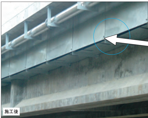
● 橋梁添架 多条を軽量コンパクトに配管
